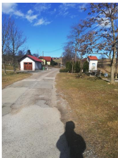
Slika 2: Prikaz obstoječega stanja terena Zgornja Senarska – 2. del.
